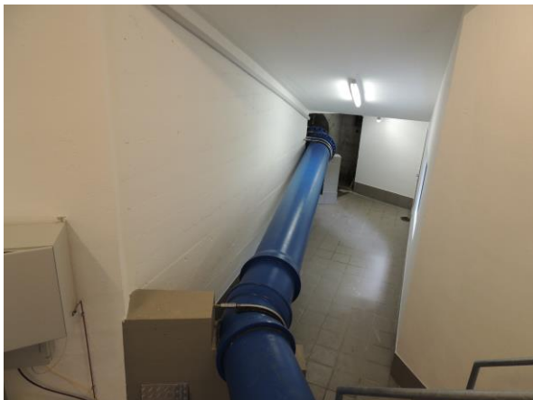
Galerie de liaison entre la galerie existante et la salle des vannes
