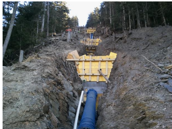
Traverse de stabilisation
