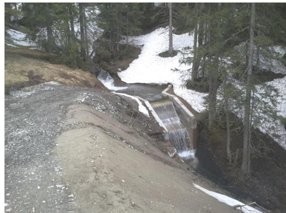
Prise d'eau sur le Bruellan
