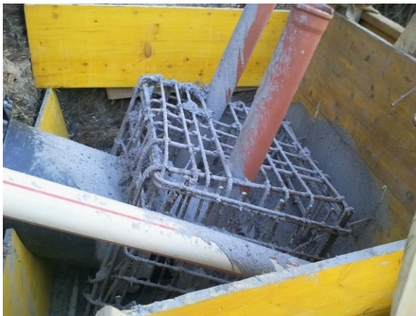
Socle d'ancrage
