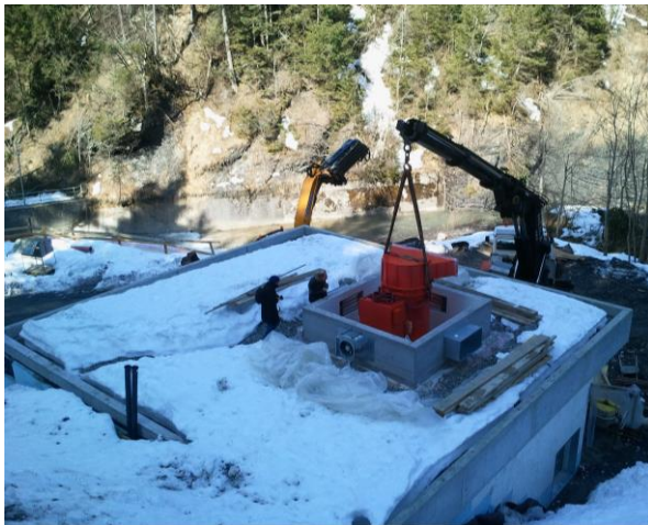
Montage de l'alternateur
