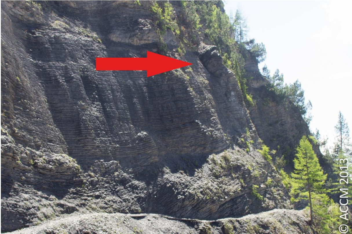
Un exemple d'un pilier rocheux qui menace le chemin.
